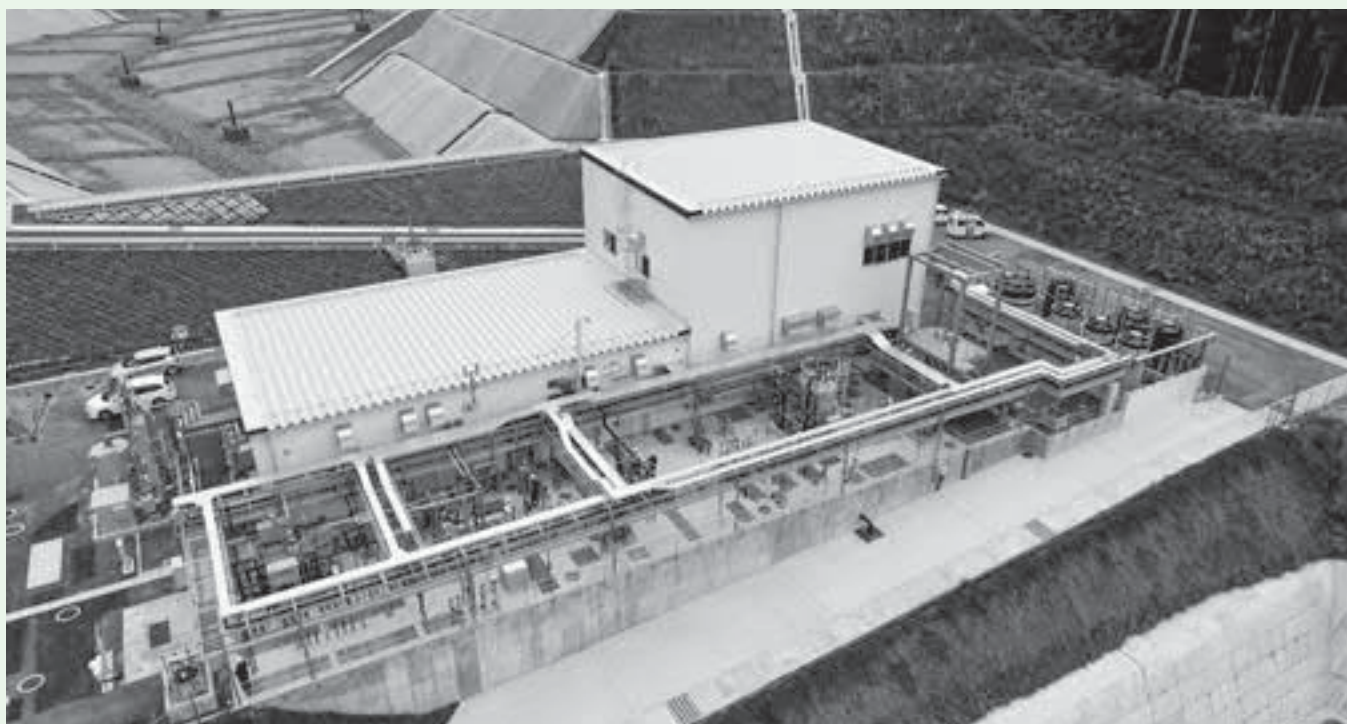
平太郎浸出水処理施設
