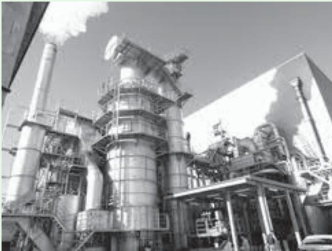
ストーカ炉側から見た焼却施設
