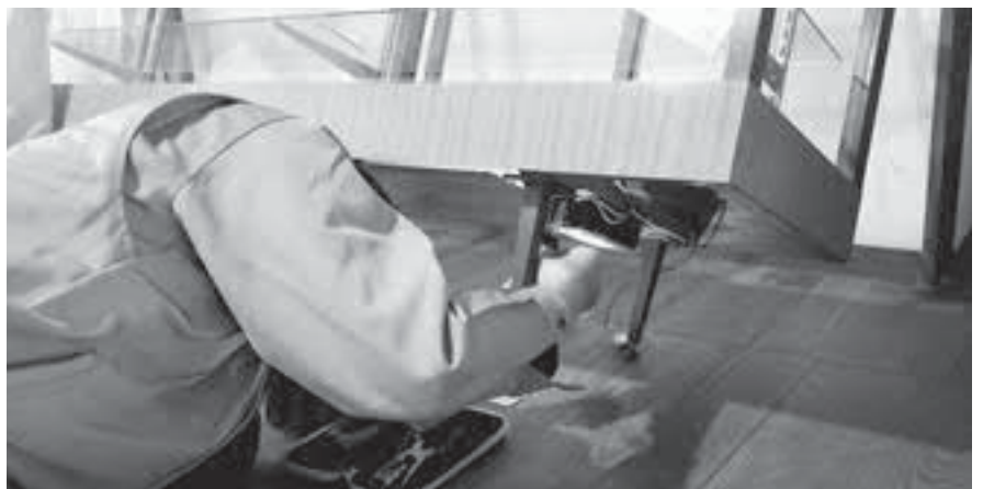
写真2 スリムラインランプ用安定器を調査
