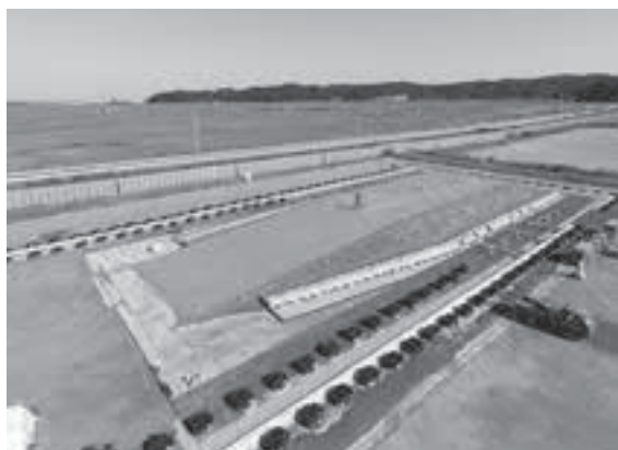
除去土壌再生利用実証事業 (南相馬市小高区)
